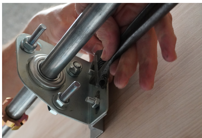
10. Monter derefter fjederbrudssikringen i beslaget og fastgør det til afstandsbeslaget på væggen.
