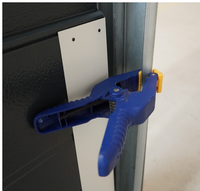
2. Fastgør panelet med en skruetvinge. Sørg for at panelet er centreret i portåbningen ved at måle afstanden fra panel til CE-skinne i begge sider.
