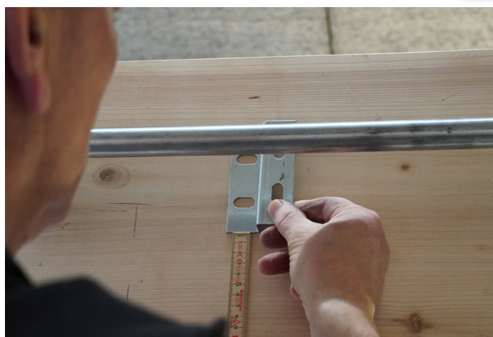
9. Mål og afmærk midten af porthullet. Sæt afstandsbeslagene 8 cm fra det afmærkede mål..
