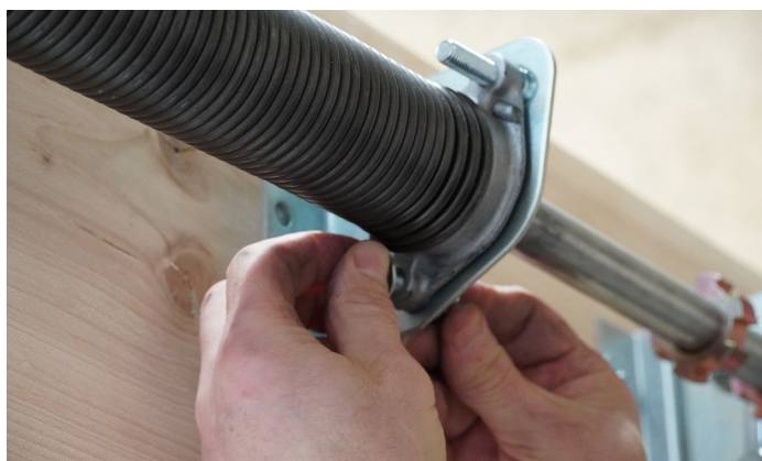
11. Fastgør fjederen til fjederbrudssikringen
